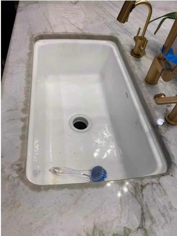
Bild 2: Fleckbild an den Schnittflächen im Beckenbereich
