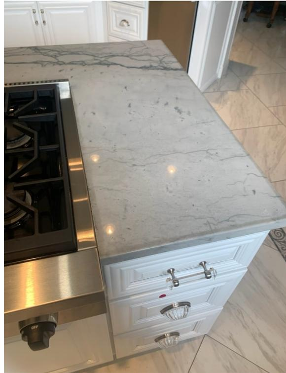
Bild 3: Auftretende Kantenverfleckungen nach wenigen Monaten
