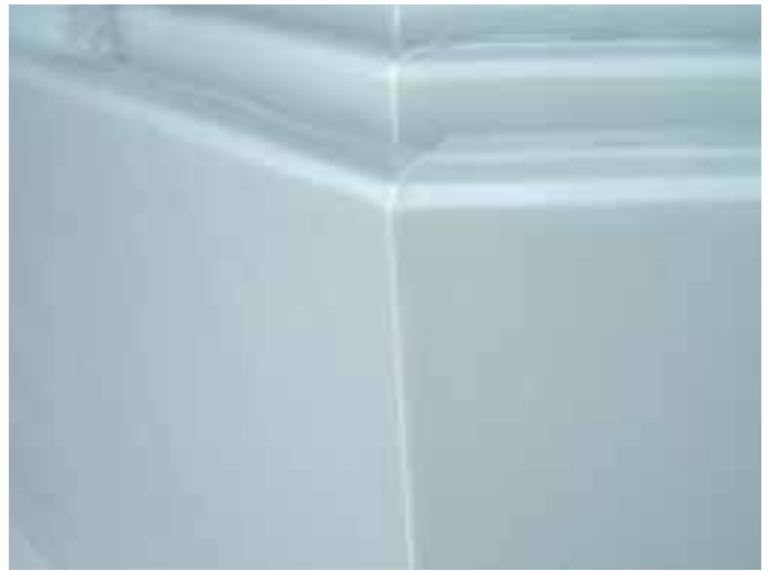
Verklebung mit AKEPOX 5010
