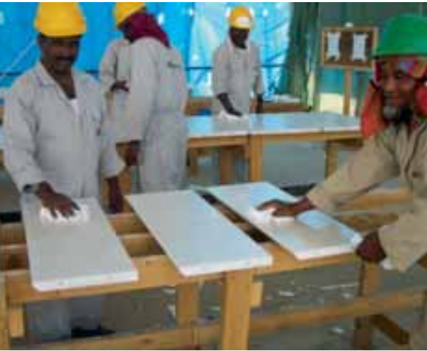
Imprägnierung der Fassadenelemente: Nach dem Auftragen von AKEMI Antifleck Super, werden die Überstände der Imprägnierung abgewischt
