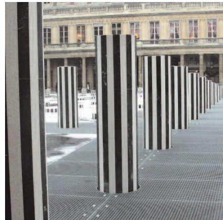
Baustelle Säulenrestaurierung (links vorher, rechts nachher): Die Restaurierung der Stelen aus Terrazzo mit Intarsien aus Nero Marquina mit anschließender Politur beseitigte Ausbrüche, Abplatzungen und Verwitterungerscheinungen.
