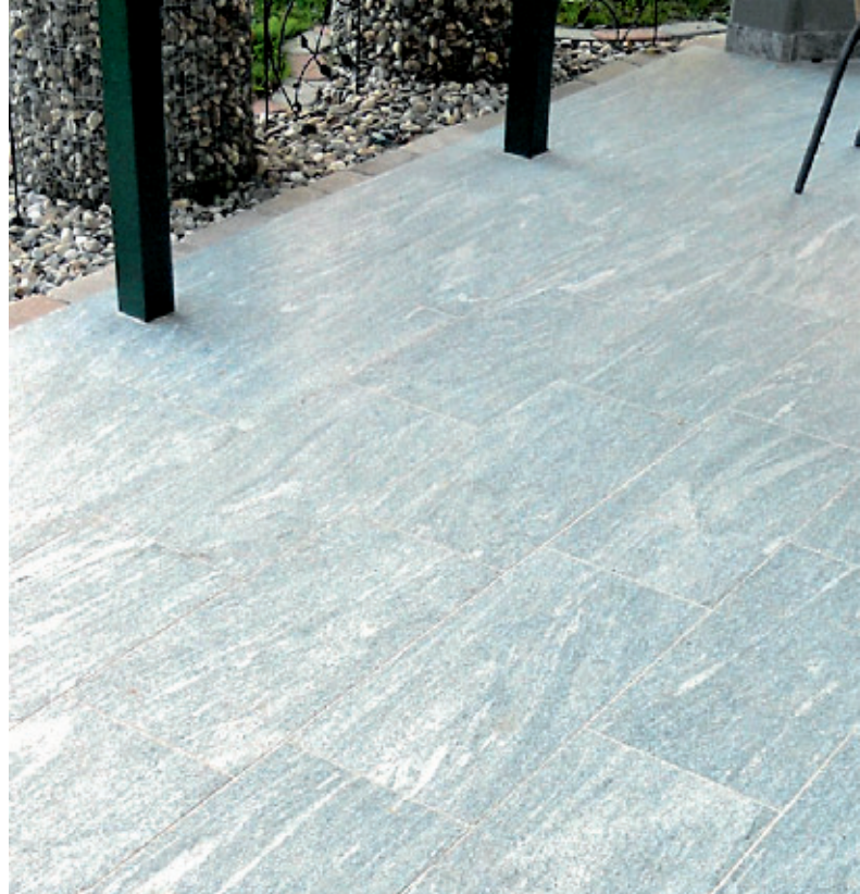
Mit rückseitiger Beschichtung werden Flecken und Ausblühungen durch aufsteigende Feuchtigkeit vermieden.
