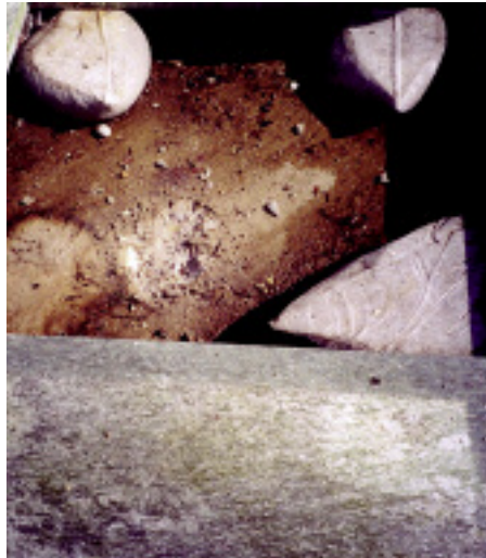
Bleibende farbliche Veränderungen durch Feuchtigkeit aus dem Untergrund in einem auf Mörtelbatzen verlegten Belag aus dem Orthogneis Andeer Fotos: Mapei
