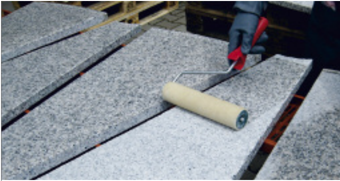
Bei der allseitigen Imprägnierung wird das Imprägniermittel rundum aufgerollt. Dadurch wird die Wasseraufnahme stark reduziert, auch an den Plattenflanken.
