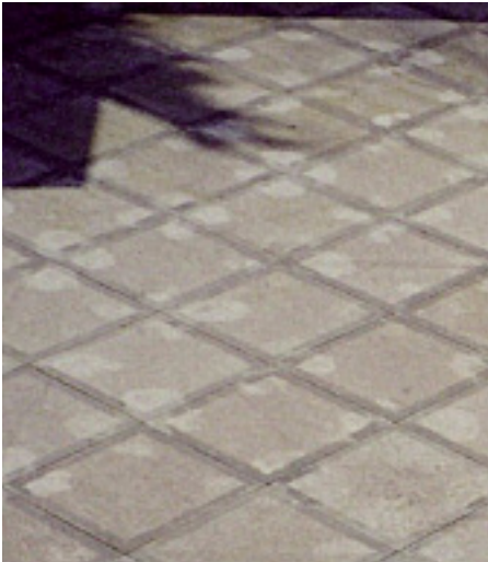
Bleibende farbliche Veränderungen durch Feuchtigkeit aus dem Untergrund in einem auf Mörtelbatzen verlegten Belag aus dem Orthogneis Andeer Fotos: Mapei
