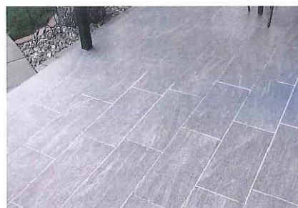
Mit Akemi Anti Stain Coating 2015 geschützter Terrassenbelag
