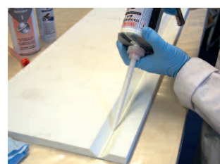
Einbringen des Color Bond-Klebers in die Gehrungsfuge
