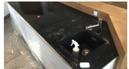
Eingebürsteter Imprägnierungsentferner in der abgeklebten Küche
