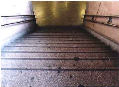
Escaleras de la estación de Estrasburgo tres años después de su tratamiento con AKEPOX® 4050 Anti Slip Mix .
