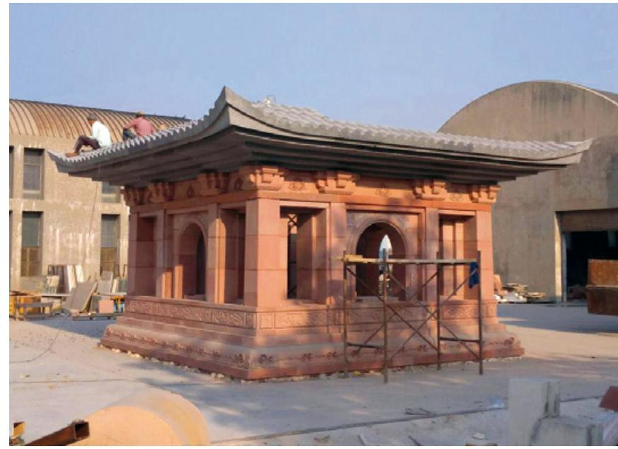
Um alle Bauelemente auf Passgenauigkeit zu prüfen, wurde die Pagode zunächst auf dem Werksgelände in Indien aufgebaut.
