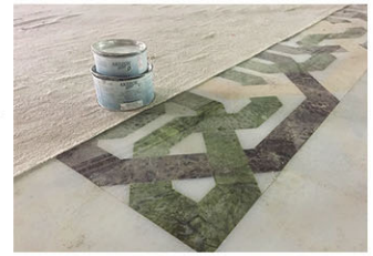
Mit Akepox 5010 verlegter Bodenabschnitt
