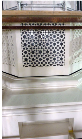
Montage der Verkleidung um die Säulen Fotos: Firma
