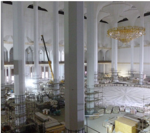
Im großen Gebetsraum wurden das Bodenmosaik und die Säulenverkleidungen aus Marmor mit Akemi Akepox 5010 verklebt.
