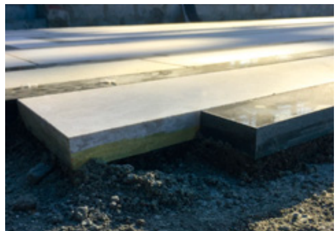
Diese Steine sind mit Anti-Stain Coating 2015 beschichtet und rückseitig mit Quarzsand besandet (Körnung ca. 0,6 - 1,2 mm).
