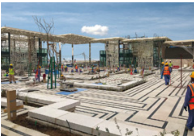
Die Marsa Plaza in Maskat kurz vor der Fertigstellung: Verlegt wurden 5.000 m 2 der osmanischen Marmorsorte DESERT ROSE.
