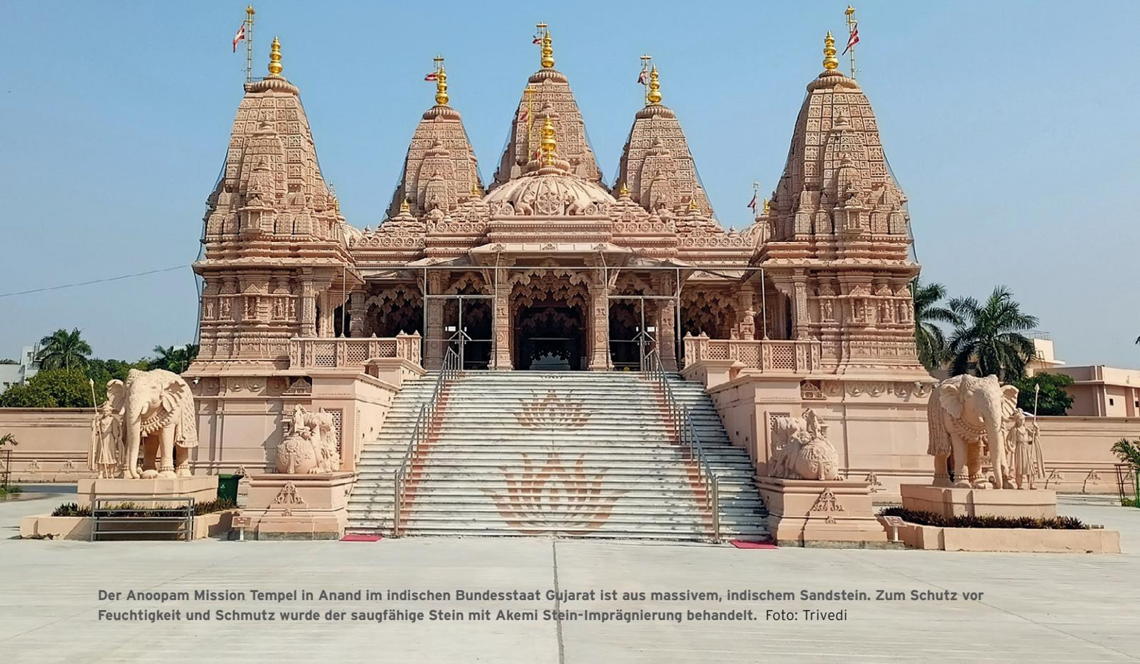
Der Anoopam Mission Tempel in Anand im indischen Bundesstaat Gujarat ist aus massivem, indischem Sandstein. Zum Schutz vor Feuchtigkeit und Schmutz wurde der saugfähige Stein mit Akemi Stein-Imprägnierung behandelt. Foto: Trivedi
